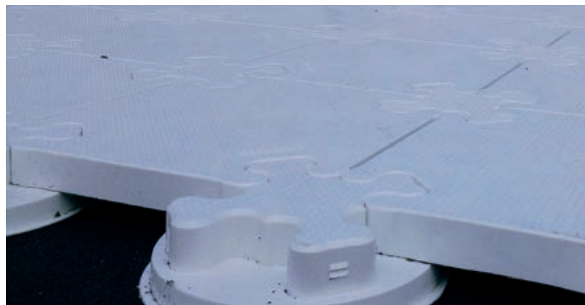
Onder de tegels bevindt zich een luchtspleet van ongeveer 2,5 cm.
